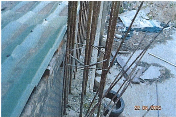
სურ. 93. რკ/ბ სვეტის ზედაპირულად კოროზირებული არმატურის ღეროების ნაშევრები.
