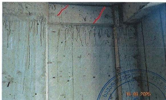
სურ. 38. ბეწისებური ბზარები რკ/ბ რიგელზე (სურათზე მონიშნულია წითელი კონტურით).
