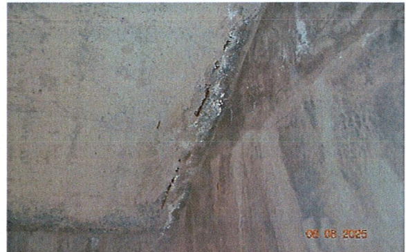
სურ. 83. რკ/პ კიბის პანდუსი, არავიბრირებული ზონა სურ. 84. რკ/პ კიბის პანდუსი, არავიბრირებული ზონა და ზედაპირულად კოროზირებული არმატურის ღეროები და ზედაპირულად კოროზირებული არმატურის ღეროები
