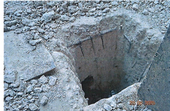
სურ. 90 რ/ბ როსტვერკი (რანდკოჭი), ფრაგმენტული გახსნა
