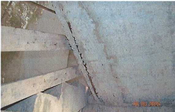
სურ. 83. რკ/პ კიბის პანდუსი, არავიბრირებული ზონა სურ. 84. რკ/პ კიბის პანდუსი, არავიბრირებული ზონა და ზედაპირულად კოროზირებული არმატურის ღეროები და ზედაპირულად კოროზირებული არმატურის ღეროები
