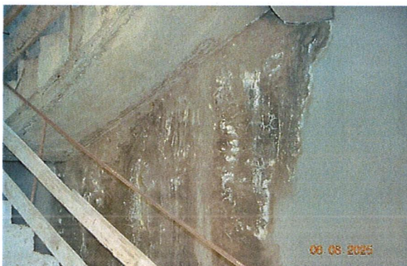
სურ. 61. დანესტიანებული რკ/ბ კედლის ზედაპირი
