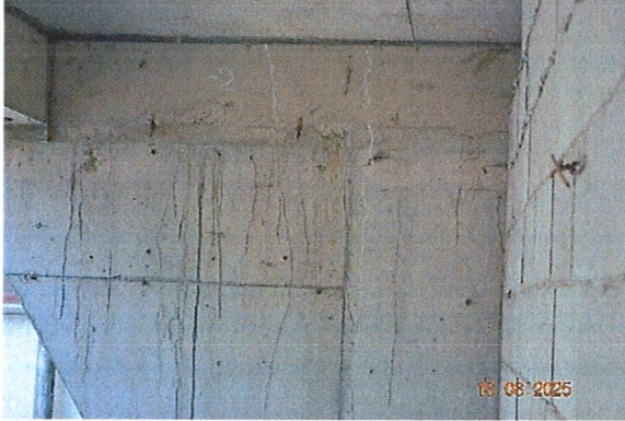
სურ. 51. ვერტიკალური მიმართულების ბეწვისებური ბზარები რკ/ბ კედელზე.
