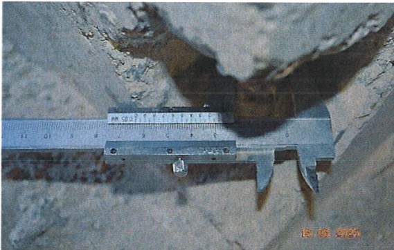
სურ. 19. რკ/ბ სვეტის ფრაგმენტული გახსნა, არმატურის დიამეტრის დადგენა.
