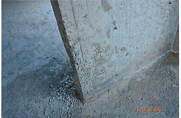
სურ. 77. ბეწვისებური ბზარი მონოლითური რკ/ბ კედელზე (სურათზე დეფექტები მონიშნულია წითელი კონტურით) სურ. 78. რკ/ბ კედელის ზედაპირზე არაევიბრირებული უბანი
