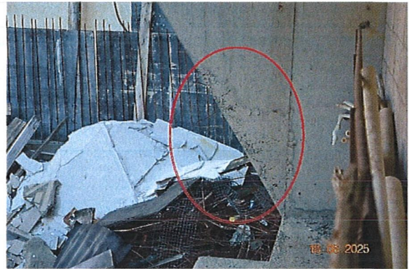
სურ. 51. ვერტიკალური მიმართულების ბეწვისებური ბზარები რკ/ბ კედელზე.
