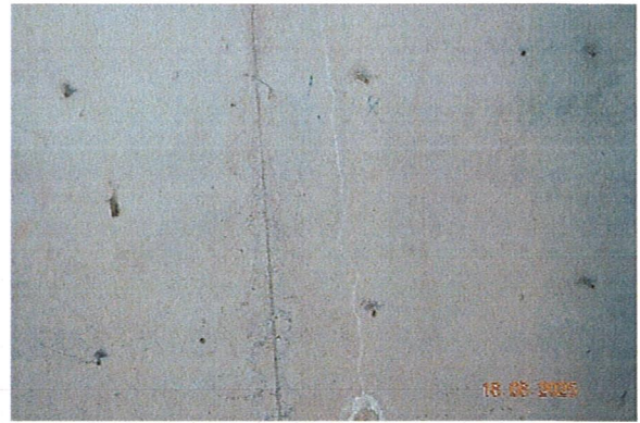
სურ. 68. ბეჭისებური ბზარი მონოლითური რკ/ბ კედელზე
