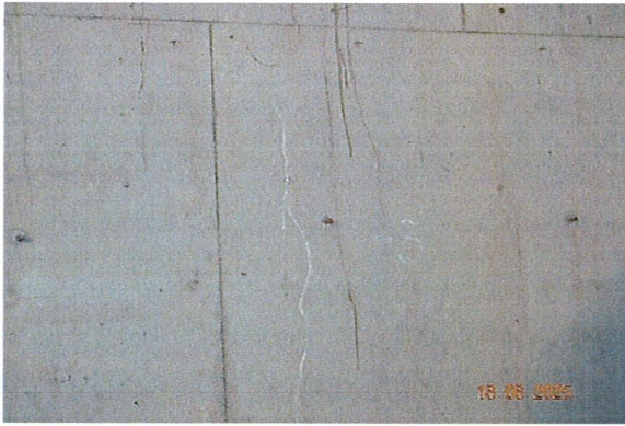
სურ. 67. ბეჭისებური ბზარი მონოლითური რკ/ბ კედელზე
