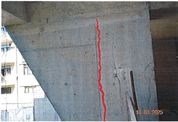
სურ. 75. ბეწვისებური ბზარი რკ/ბ კონსოლურ კედელზე (სურათზე დეფექტები მონიშნულია წითელი კონტურით) სურ. 76. ბეწვისებური ბზარი რკ/ბ კონსოლურ კედელზე (სურათზე დეფექტები მონიშნულია წითელი კონტურით)
