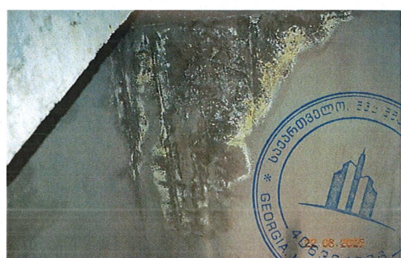
სურ. 62. დანესტიანებული რკ/ბ კედლის ზედაპირი
